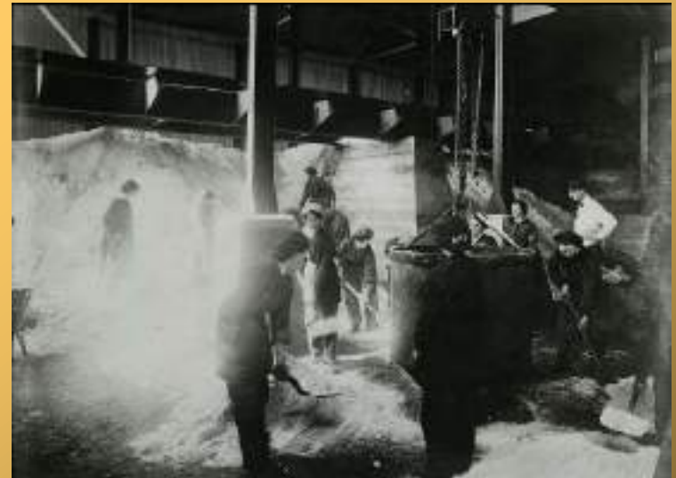
Wrzucanie azotanu sodu do kontenera
